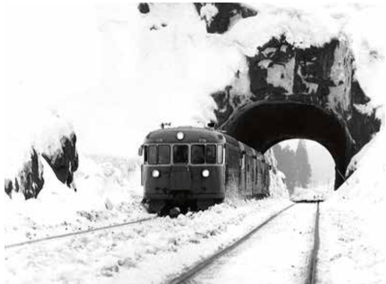
Ensimmäinen juna kulkemassa Espoon tunnelin läpi 1.11.1966
